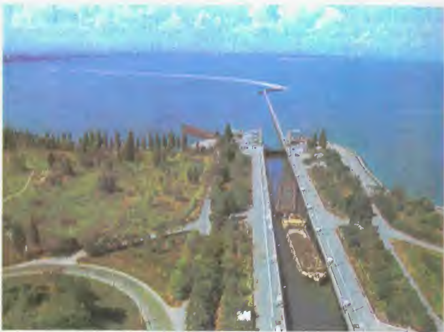
Кременчуцьке водосховище. Судноплавний шлюз з аванпортом.
